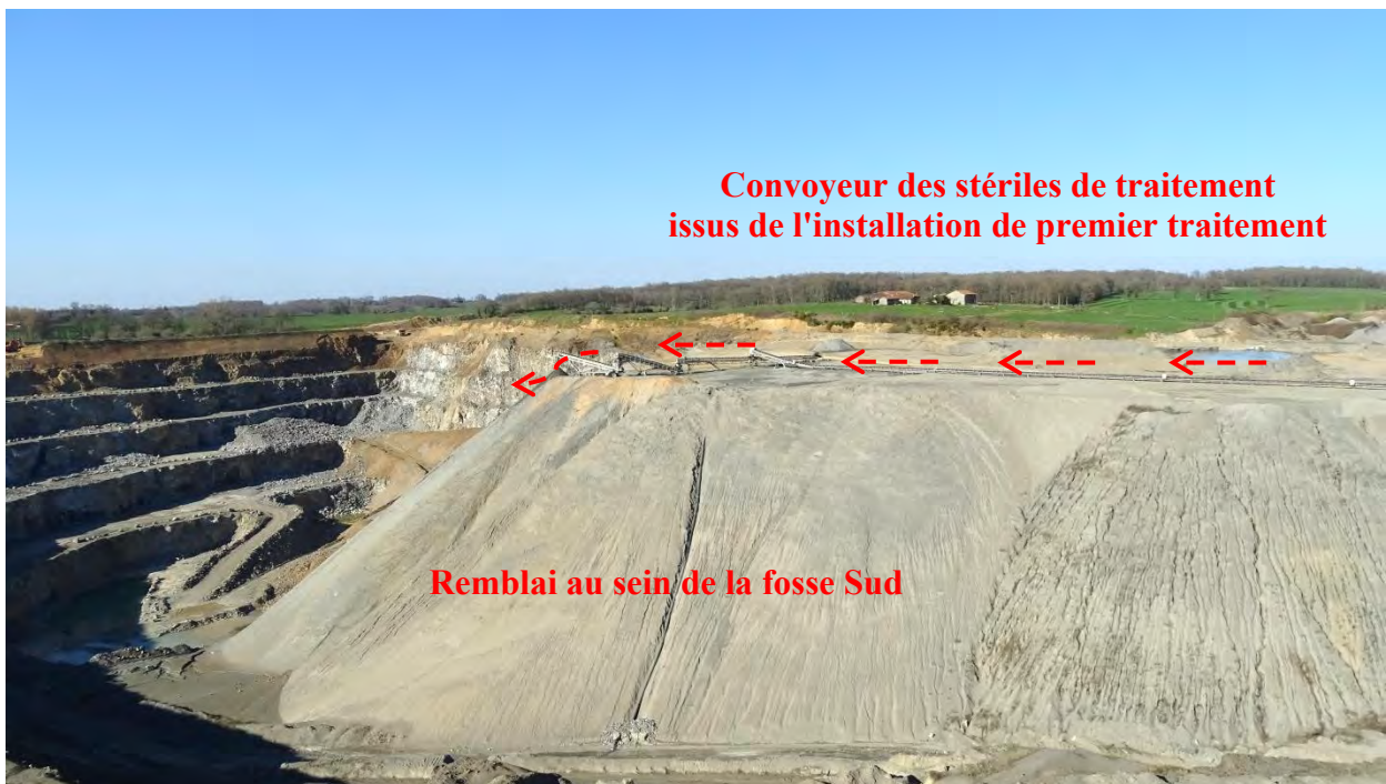
Convoyeurs d'évacuation des matériaux stériles
