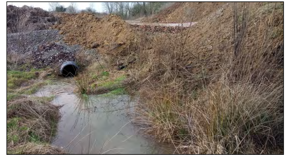
Ru de Juillac busé au droit de l'emprise autorisée de la carrière (Tronçon VII)
